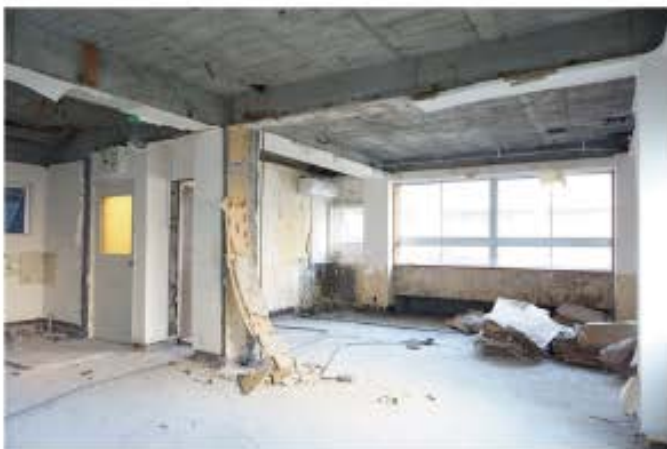
(内装工事前のスケルトン状態)
