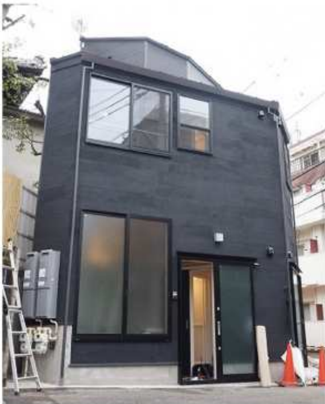
(工事中の外観)
